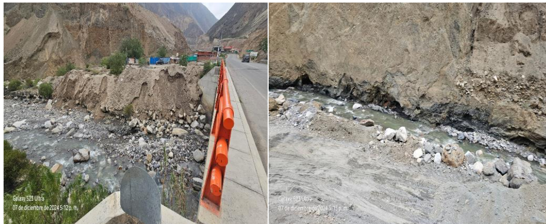
FOTOGRAFIA 02: Vista en la que se aprecia la carencia de diques secos con acumulacion de material propio en ambas márgenes del río.
